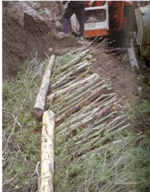
Detalle de ejecución, ramas colocadas en la trinchera antes del relleno de tierras
