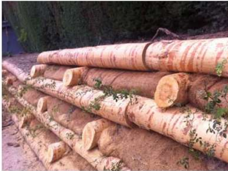
Entramado vivo recién construido.
